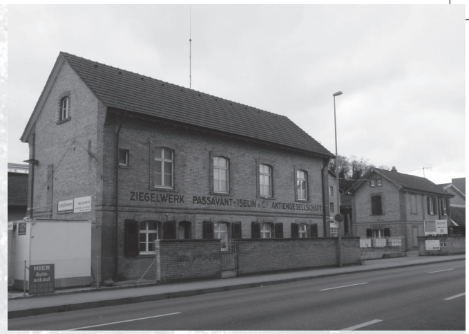
Abb. 3: Einzelne Gebäude der beiden ehemaligen grossen Allschwiler Ziegeleien stehen heute noch. Hier Teil der Ziegelei Passavant-Iselin & Cie. (Fotos: Rebekka Schifferle)
